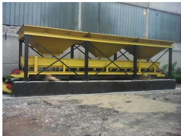
Монтаж бетонного завода FERRUM MIX 60ST
