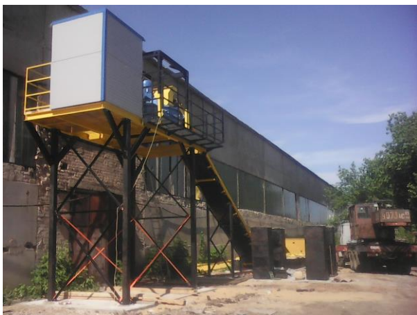
Монтаж бетонного завода FERRUM MIX 60ST
